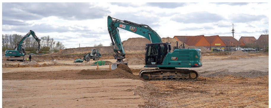
An der Damgartener Chaussee – nur wenige Meter vom derzeit bestehenden Norma-Markt entfernt – entsteht eine neue Filiale der Discounterkette.
