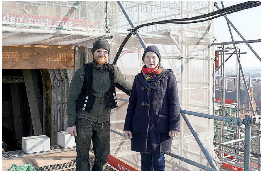
In luftiger Höhe: In St. Marien sind die Arbeiten in vollem Gange. Pastorin Susanne Attula (r.) und Zimmerermeister Jonas Heinze freuen sich über den Fortschritt.
